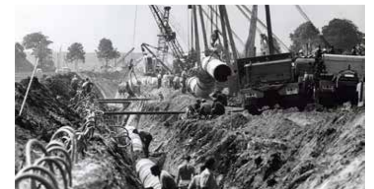
Aanleg van een aardgasleiding in de jaren '60 van de vorige eeuw toen in rap tempo een gasnetwerk in Nederland werd aangelegd.
