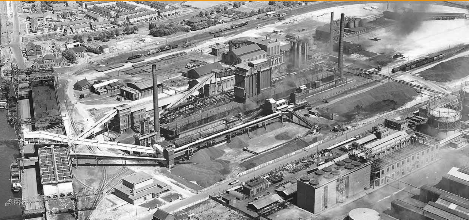
De cokesfabriek (boven) in Sluiskil begin vorige eeuw, waarvan de kunstmestfabriek CNA waterstofrijk cokesgas als grondstof afnam. De pijpleiding naar de gasopslag is rechts zichtbaar.
